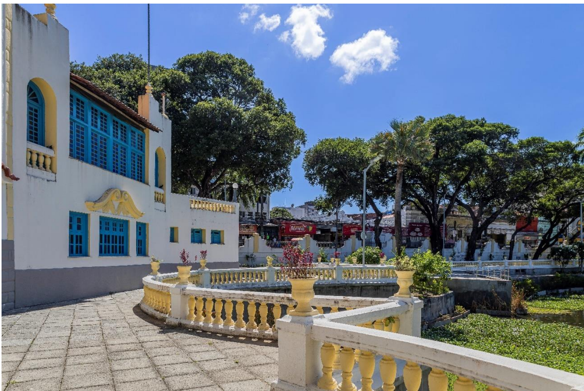
Balastrada externa ao Casarão
