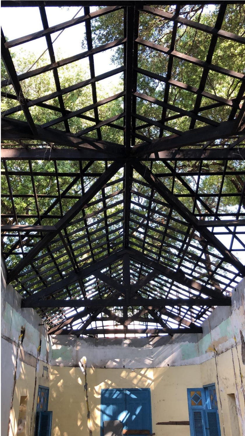
Recuperação de madeiramento das cobertas das edificações existentes no parque
