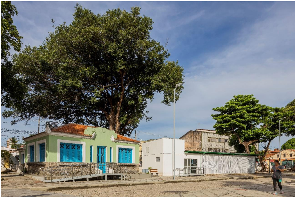
Edificação casa de apoio ao ciclista
