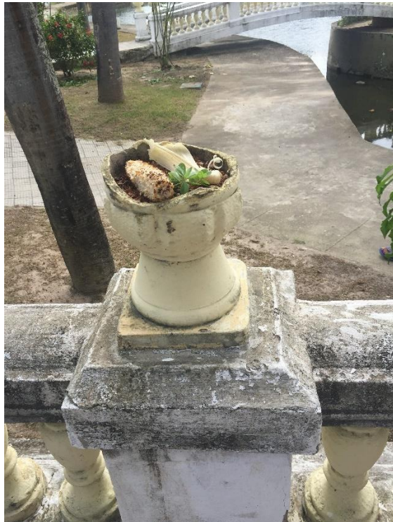
Vasos e balaustradas encontravam-se em sérios danos estruturais e com parte de seus elementos perdidos
