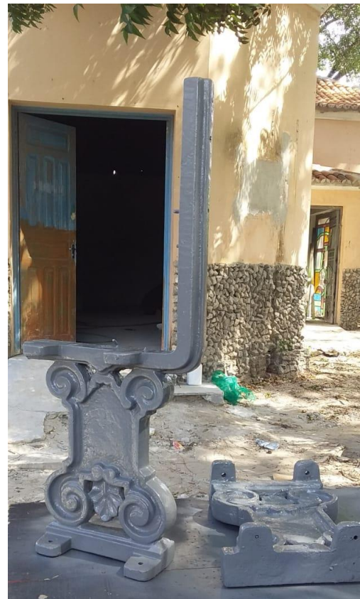
Restauro da base dos bancos em ferro fundido desenhando o brasão de Fortaleza
