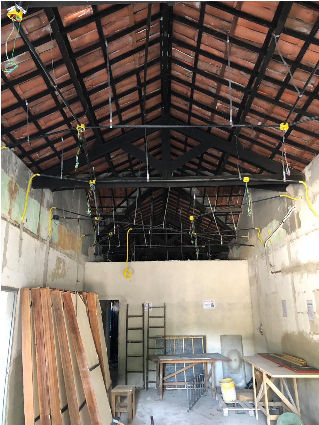
Recuperação das cobertas das edificações existentes no parque
