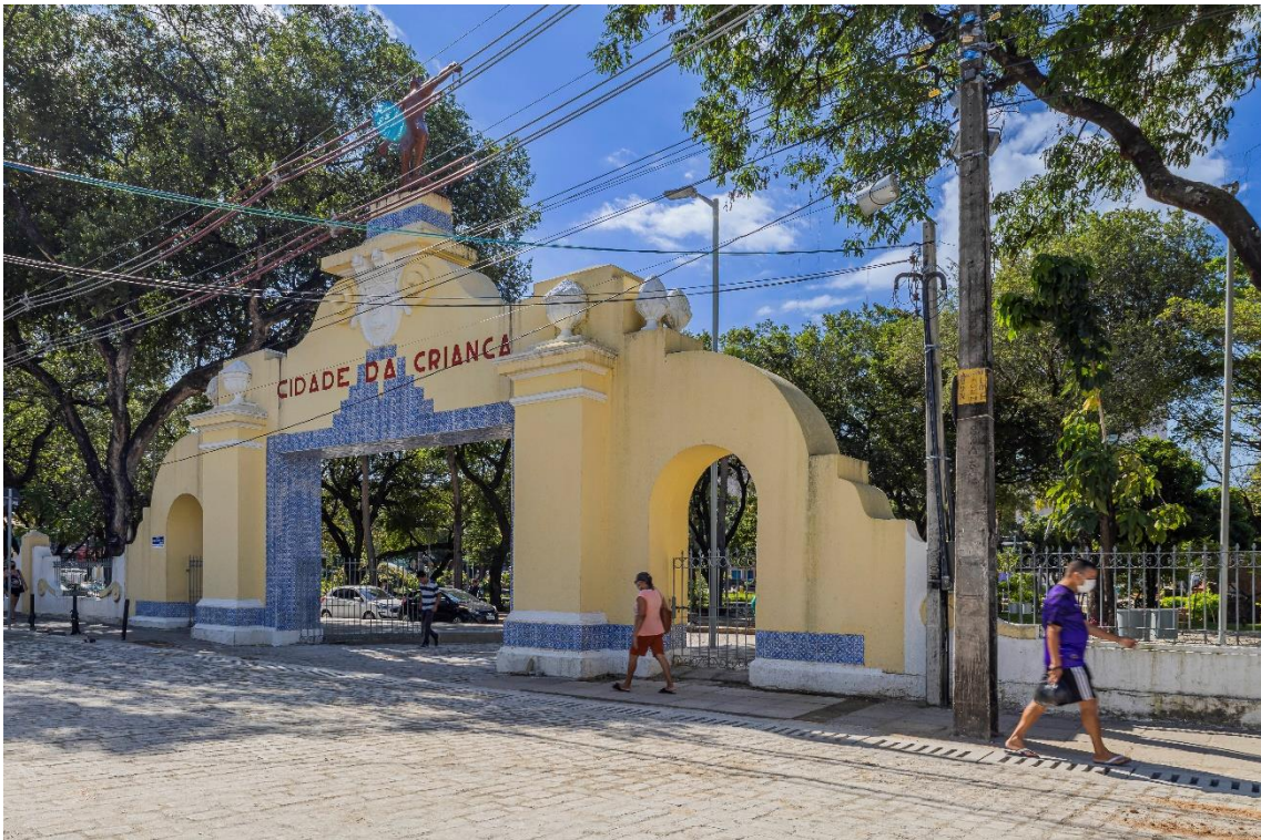
Portal principal de acesso
