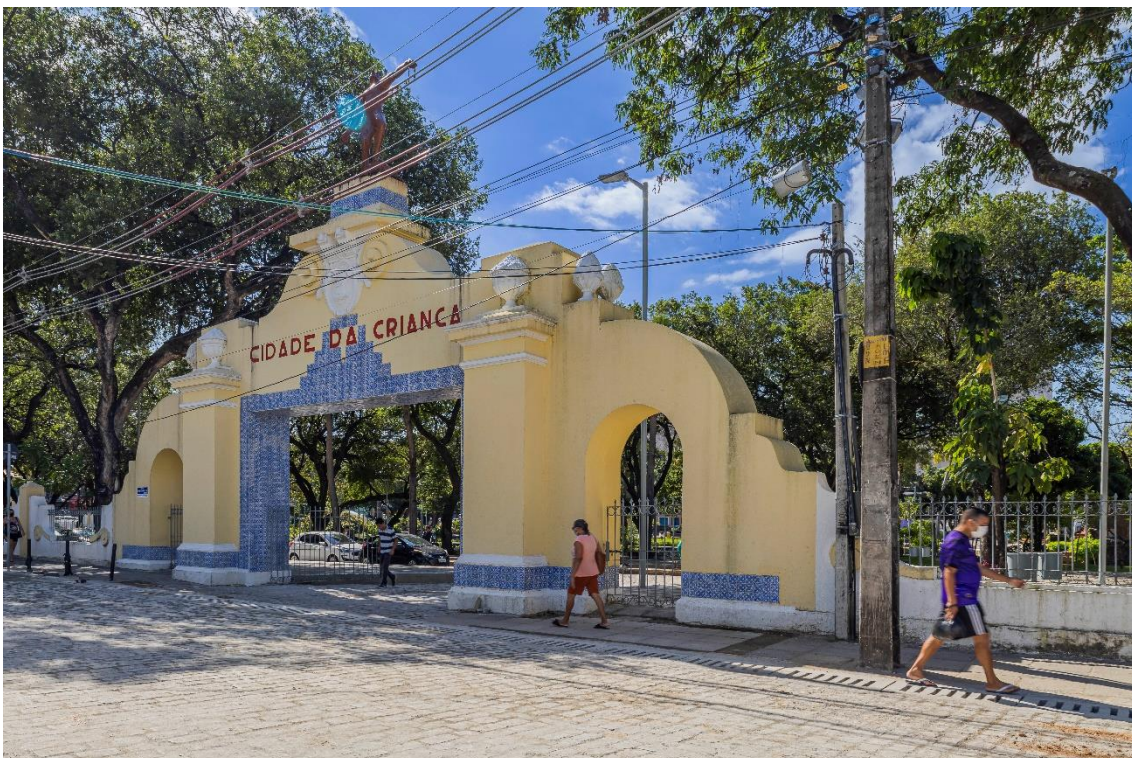
Portal principal de acesso
