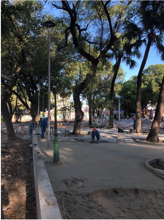
Assentamento de pavimentação em pedras de concreto drenante que garantem uma permeabilidade do solo de até 90%
