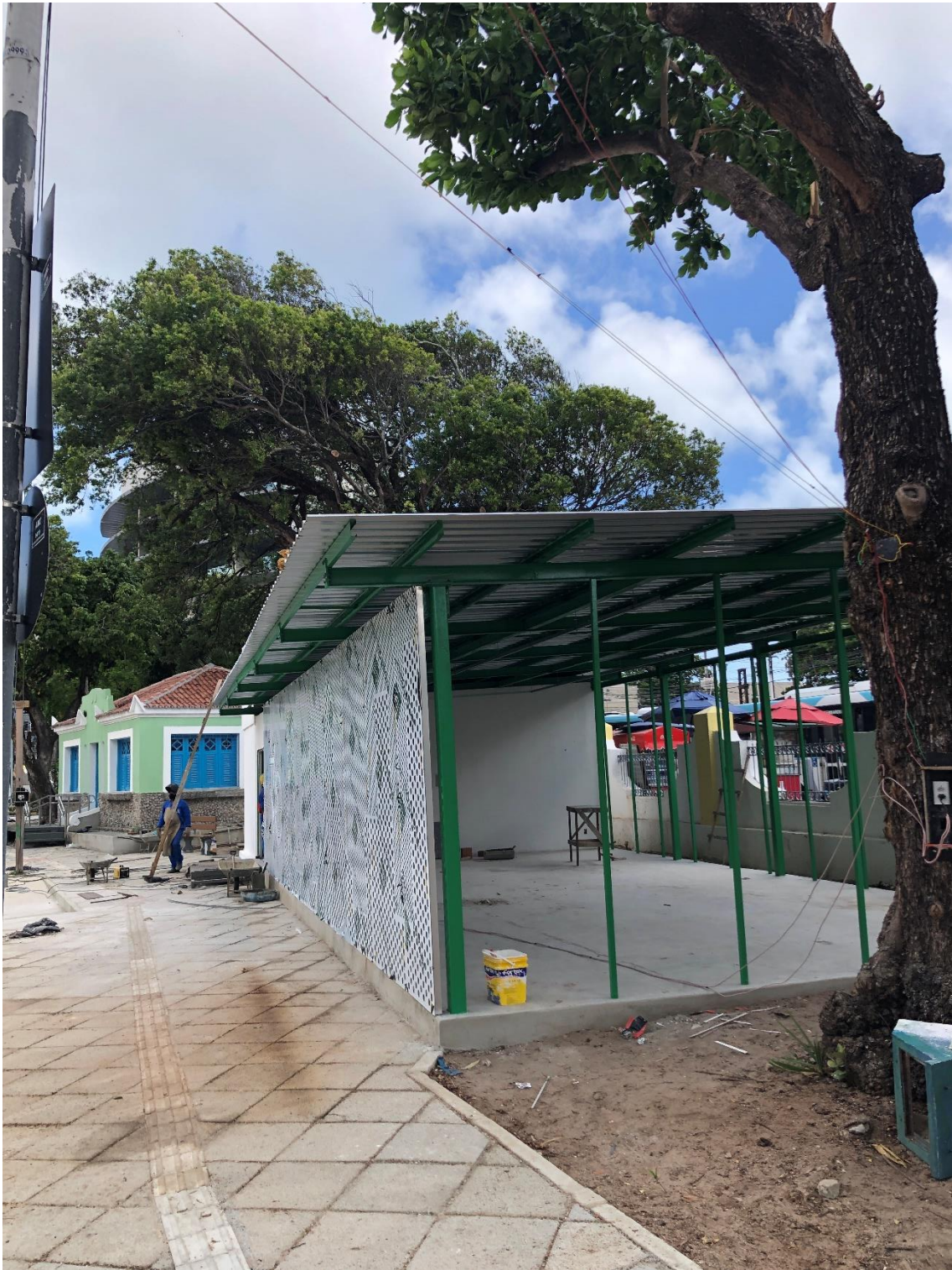
Execução da Casa do Ciclista (programa de bicicletário integrado), única edificação nova no parque, utilizando de material contemporâneo, desmontável e de fácil diferenciação dos elementos históricos.
