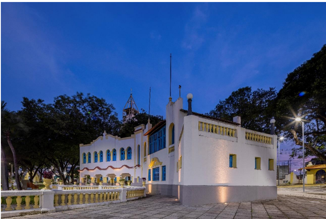
Restauro do Casarão
