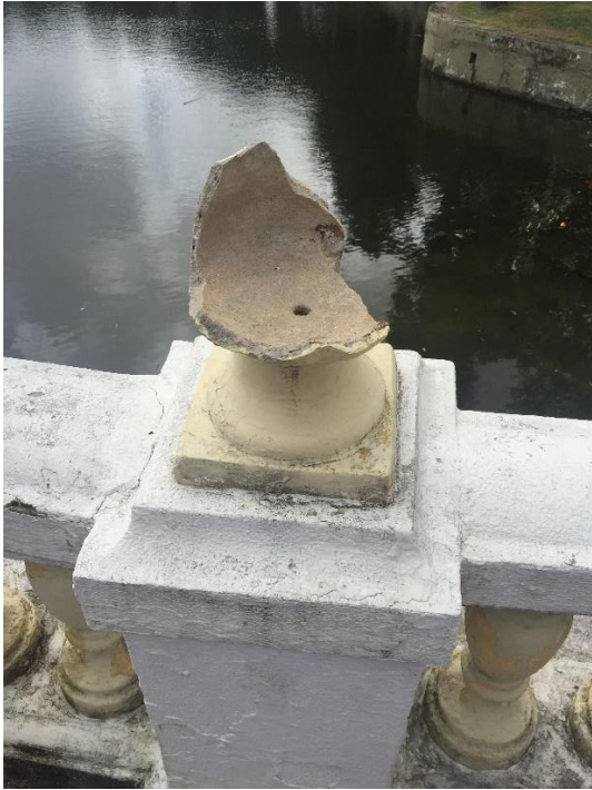
Reconstrução mimética a partir dos demais vasos ainda intactos, mas utilizando de materiais diferentes
