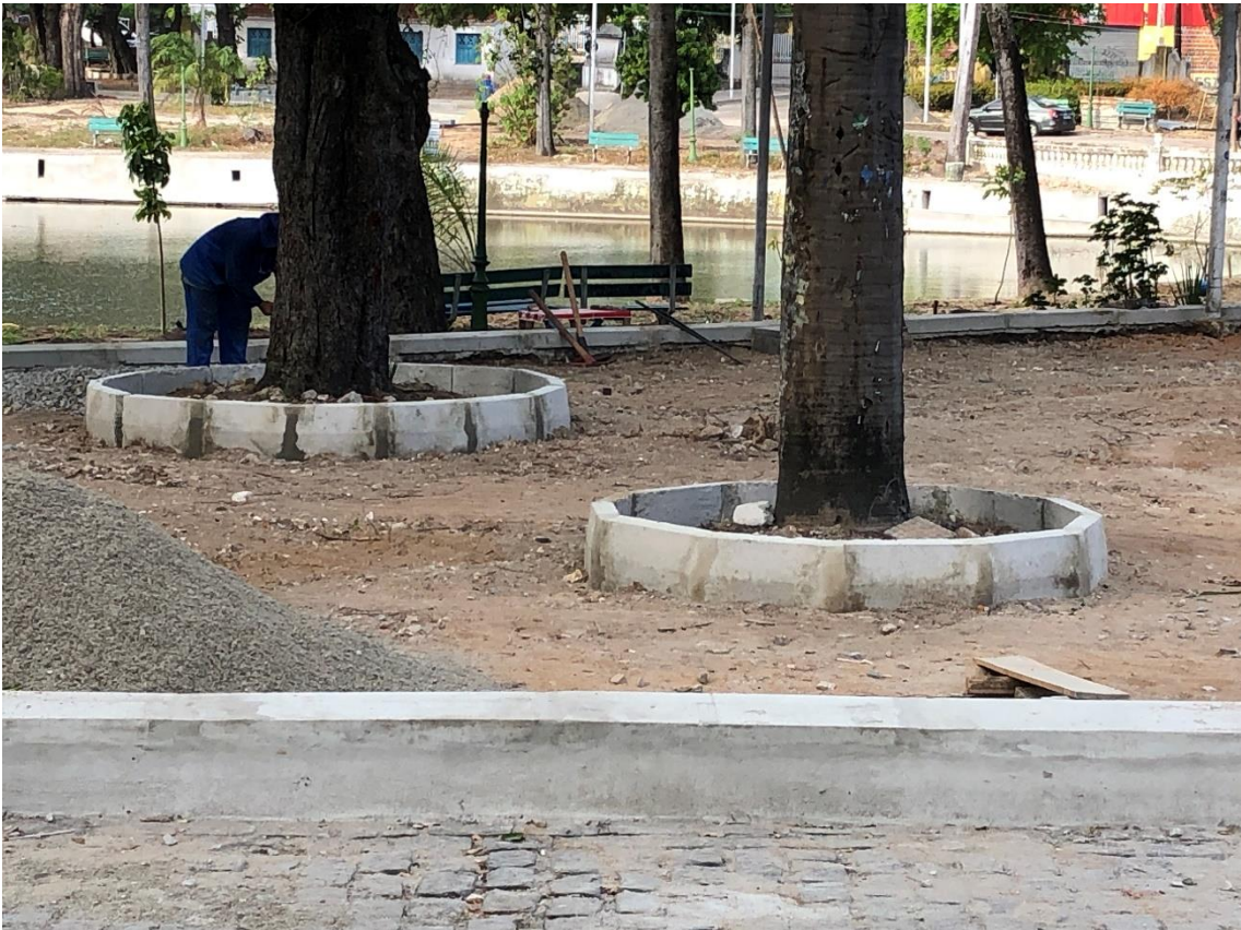
Execução das novas jardineiras dimensionadas de acordo com cada uma das espécies existentes levantadas para o projeto paisagístico e as novas espécies especificadas
