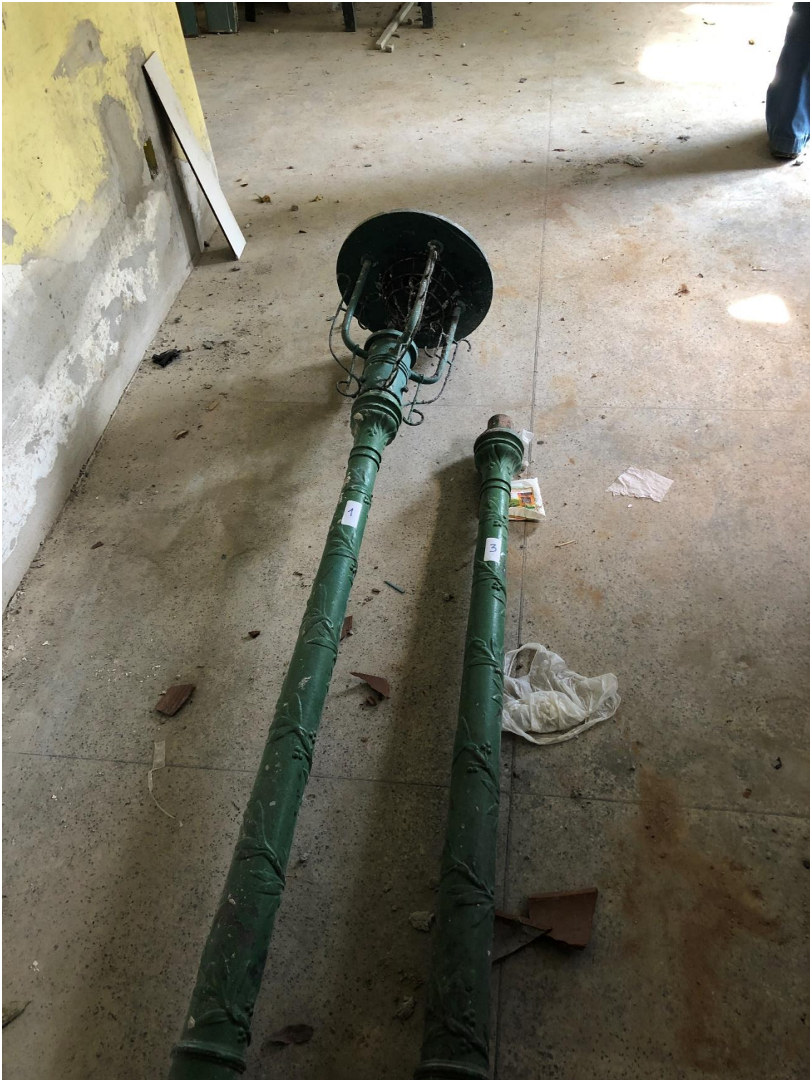
Retirada e recuperação dos postes existentes, ainda que não necessariamente recuperados do ponto de vista funcional na questão da luminância, mas estético e decorativo, o que mantém a memória visual do lugar.
