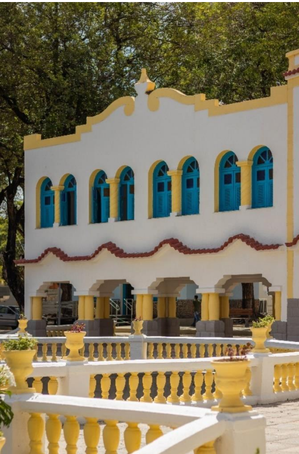
Restauro do Casaão
