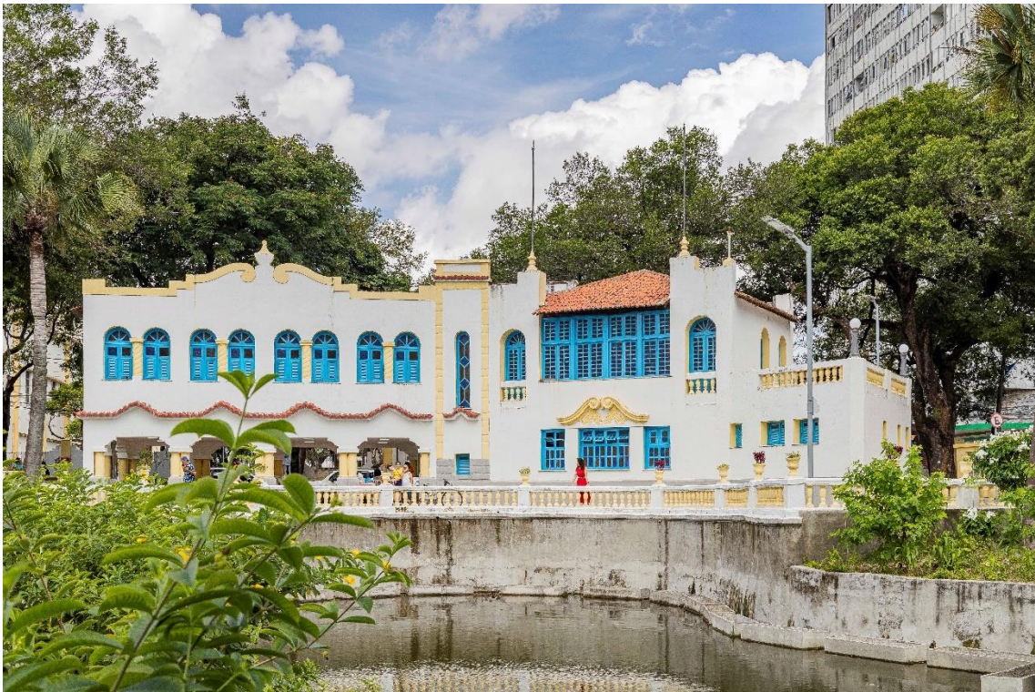
Restauro do Casarão
