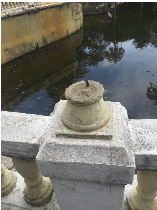
Vasos e balaustradas encontravam-se em sérios danos estruturais e com parte de seus elementos perdidos
