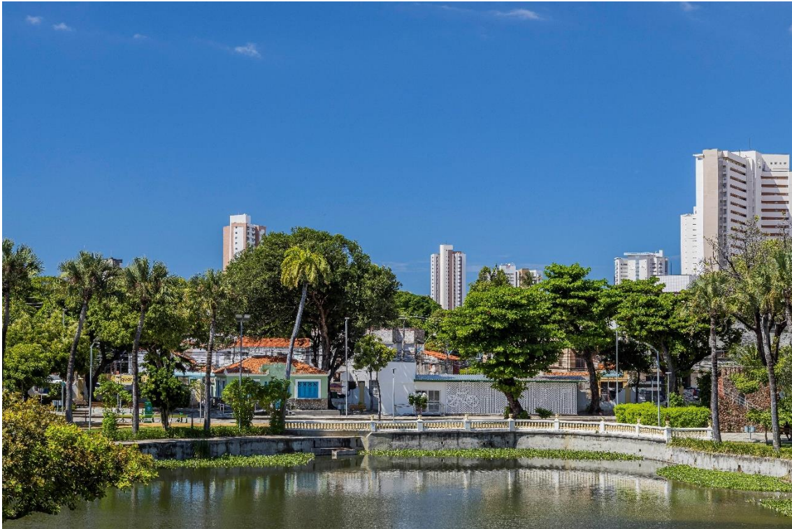
Casa do Ciclista como elemento novo no parque, mas que permite protagonismo ao parque tombado
