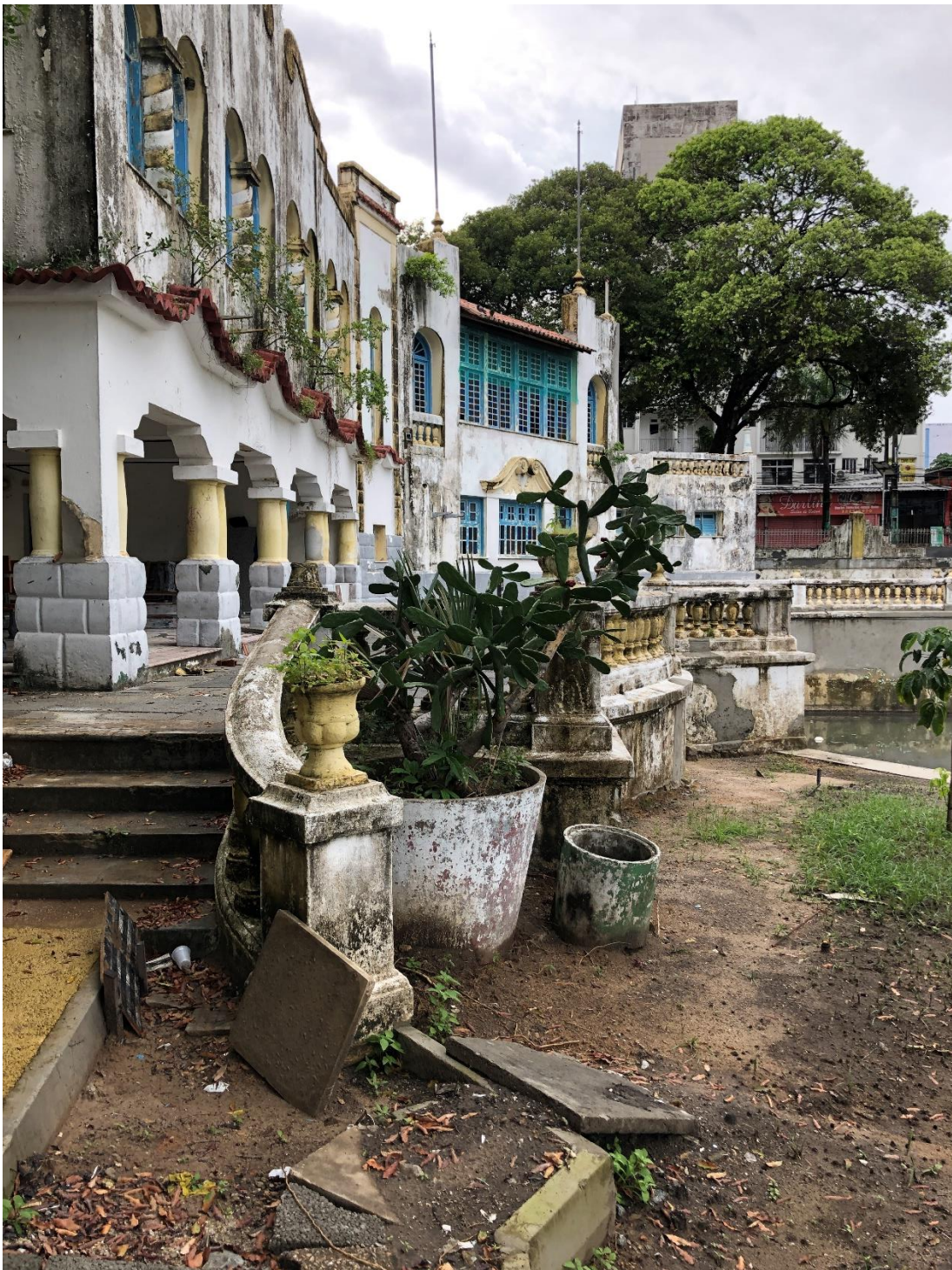
Registro feito no início de 2020, poucos dias antes do início das obras.
