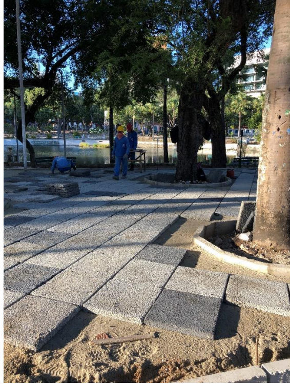
Assentamento de pavimentação em pedras de concreto drenante que garantem uma permeabilidade do solo de até 90%
